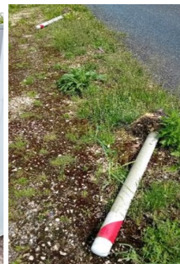
les poteaux arrachés !!
